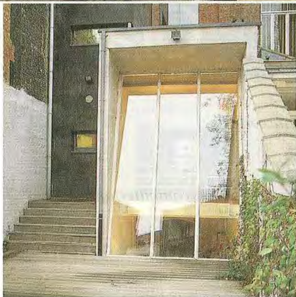
De achterbouw is sober, maar stijlvol en krachtig. Drie volumes beheersen de gevel: het oude woonhuis, de zwarte koker van de badkamer en de keuken, en de witte aanbouw met het schuine raam.
